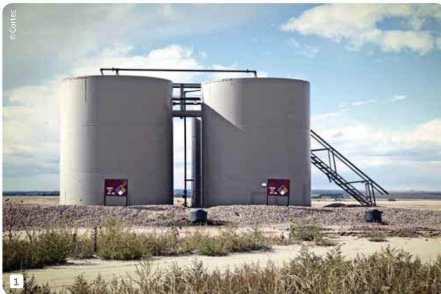
**1** The storage tanks are subject to soil-side corrosion, especially when installed in severe environments. I serbatoi di stoccaggio sono soggetti alla corrosione da terreno, specialmente se installati in ambienti aggressivi.
