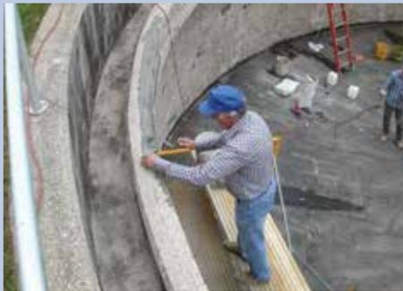
Os tanques de águas residuais ao ar livre eram originalmente construídos em 1939, e nenhum reparo foi feito em quase 20 anos, áreas corroídas e fragmentadas, assim como vergalhões expostos, tinham que ser reparados.
