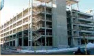
Um estacionamento para 1,800 veículos, seis andares necessitava que todos os seus 16,820 m<sup>3</sup> de concreto para cumprir ou exceder 20, 68 mpa em 18 a 24 horas.
