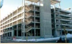
Ce parking de 6 étages pour 1800 véhicules nécessitait 20 000 mètres cube de béton capable de résister à une force de 3000psi au bout 18h à 24h .
