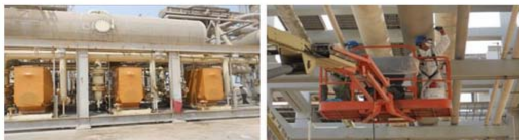
Foto: messa in conservazione di compressori e pompe per il gas (sinistra). Tubi isolati inoculati con l'inibitore VpCI® (destra).
