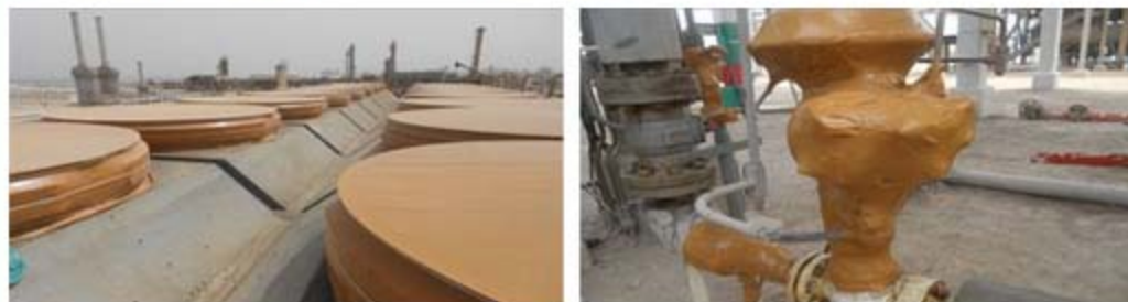
Foto: i raffreddatori ad aria sono stati rivestiti con i rivestimenti Cortec® e coperti con la pellicola anticorrosiva MilCorr® (sinistra). Macchinario protetto con la pellicola MilCorr® (destra).
