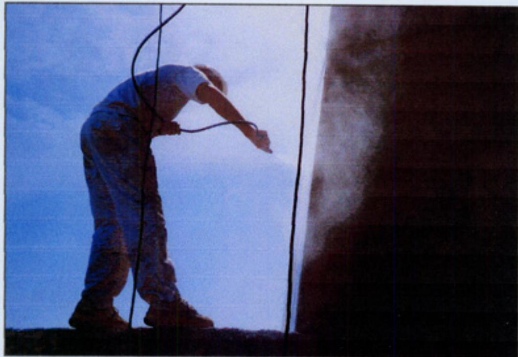
*La aplicación del inhibidor de corrosión MCI 2020 sobre la superficie va a permitir la migración del mismo hasta la armadura metálica otorgando de esta forma una protección de la misma frente a procesos de corrosión.*
