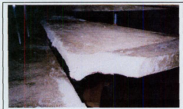
La segunda parte de la problemática era la nueva construcción de otra plataforma en el trampolín la cual debido a las especiales características de este tipo de estructuras de competición no podía mantener el recubrimiento de hormigón sobre la armadura mínimo.
