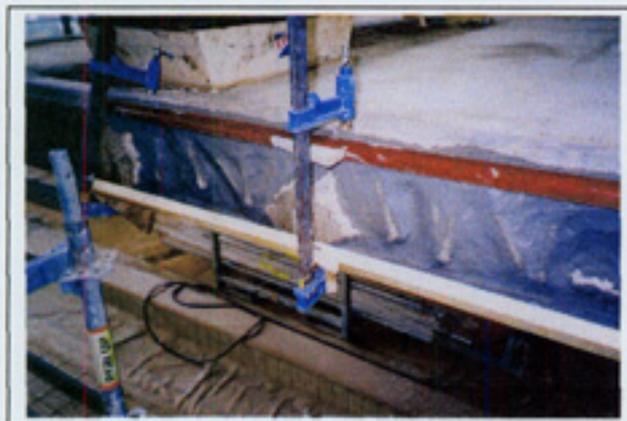
*Puente de fijación con el mortero MCI-2039.*
