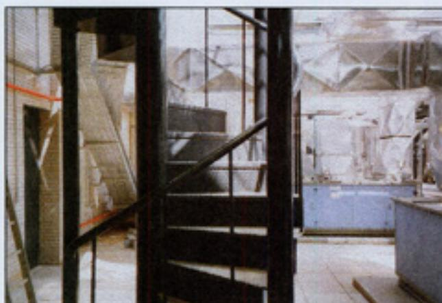
*Detalle de la base que conforma la Torre de antenas y que tiene su acceso mediante una estructura metálica en forma de escalera de caracol.*
