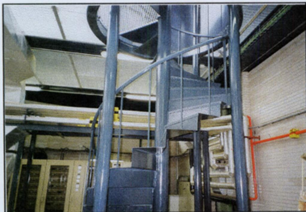
*Aspecto final del tramo inicial de la Torre de Antenas tras la aplicación del recubrimiento VCI-386 transparente y el recubrimiento en color azul.*
