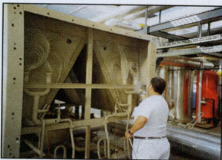
*Aplicación del recubrimiento transparente VCI-388. Este recubrimiento ofrece unas garantías de protección muy similares al VCI-386 pero su aplicación se concreta a los equipos y estructura metálica que se encuentra resguardada o bajo techo.*
