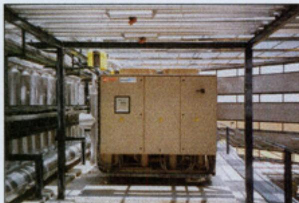
*Detalle de uno de los equipos de climatización que se encuentran ubicados en el nivel superior de la sala de climatización, este equipo al igual que parte de los del nivel inferior se encuentran expuestos a los factores atmosféricos y condiciones climatológicas ya que la conformación estructural de la sala no se encuentra totalmente cerrada al exterior.*
