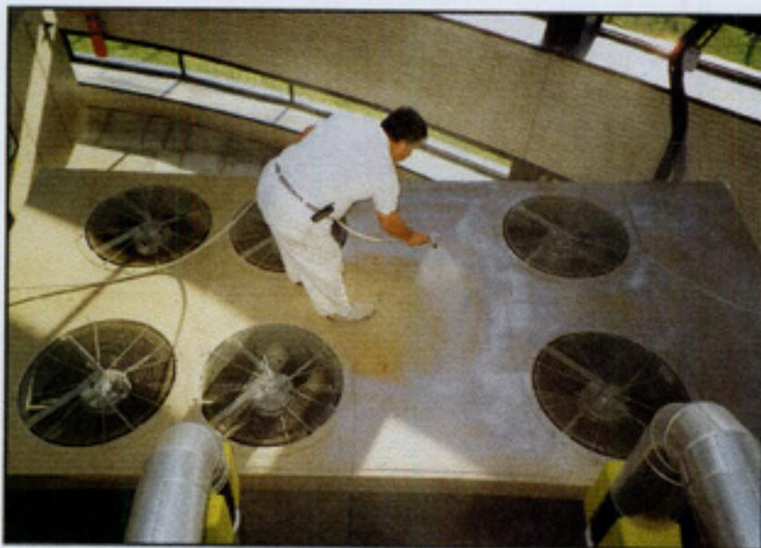
*La aplicación del VCI- 386 sobre los equipos de climatización se realiza mediante equipo a presión y manteniendo un espesor de una 85 micras. El aspecto blanquecino que se observa en la fotografía se torna transparente tras el secado del recubrimiento, dejando un brillo sobre el equipamiento*
