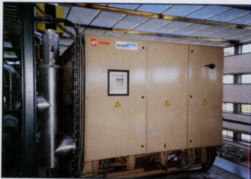
*En la fotografía se muestra el acabado del recubrimiento VCI-386 sobre la carcasa exterior de un equipo, obsérvese el aspecto brillante que otorga el recubrimiento.*
