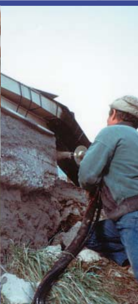
Avlägsna lös betong från den förfallna byggnaden.
