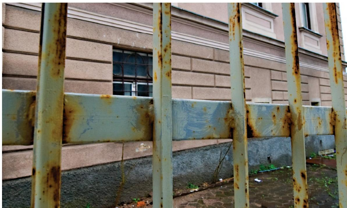
Slika 9. Atmosferska korozija čelika [8]
