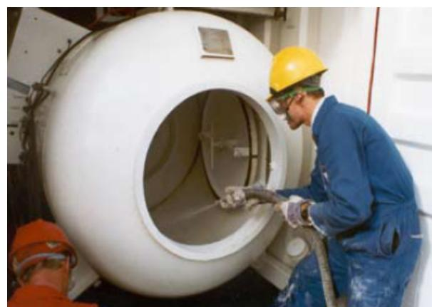
Slika 35. Metode nanošenja inhibitora u obliku praška<sup>[52],[53]</sup>
