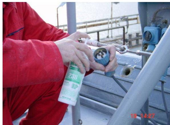
**Slika 3.b** Primjena inhibitora za zaštitu električnih kontakata [5]
