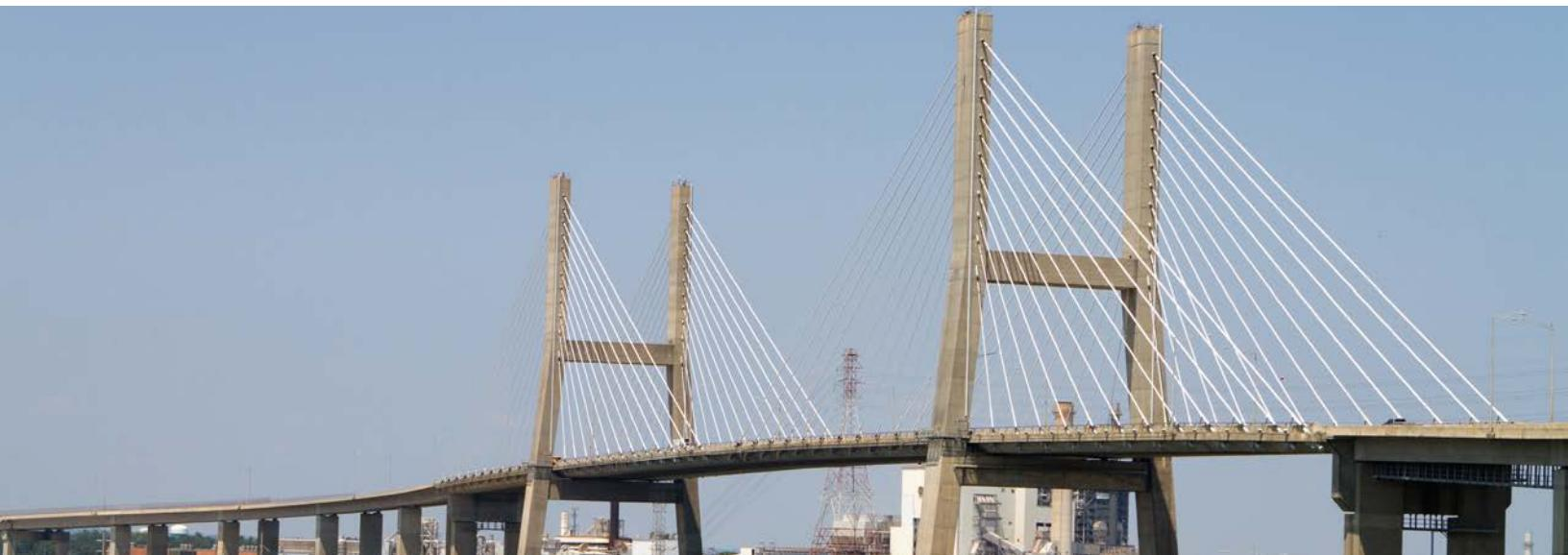
MCI® Mini Grenades su dodane mortu za injektiranje kako bi dodatno od korozije zaštitile izložene žice u kablovima na mostu Cochrane - Mobile, Alabama.
