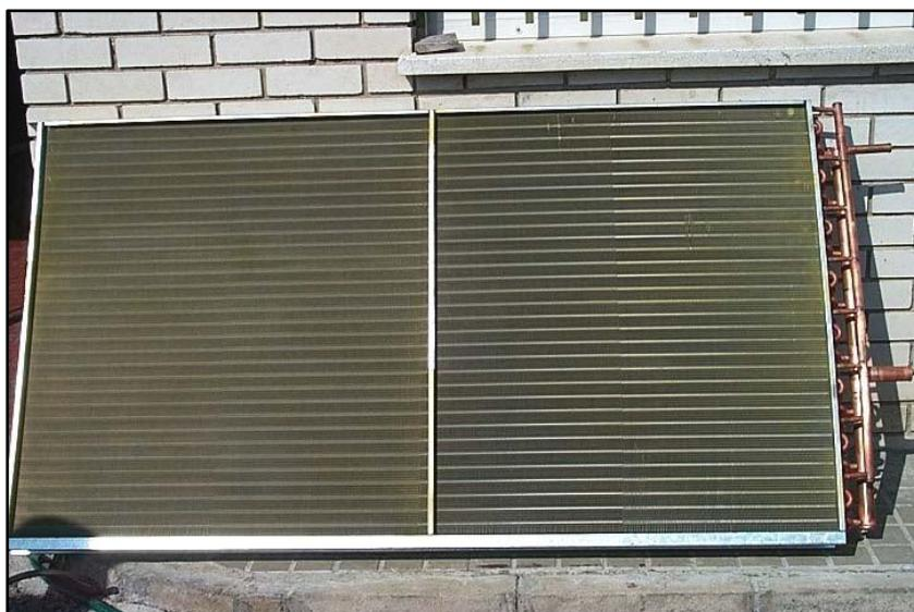
Este mecanismo de protección ha sido adoptado por Carrier para la protección de este tipo de equipamientos ya que ha resultado un método eficaz frente al grave problema de corrosión ambiental que sufren este tipo de equipos en sus componentes de aluminio. La disposición estructural de las aletas de aluminio hace que el uso de inhibidores en fase vapor VpCI sea prácticamente la única solución viable para lograr una protección efectiva en todas las zonas inaccesibles a otro tipo de protecciones.
