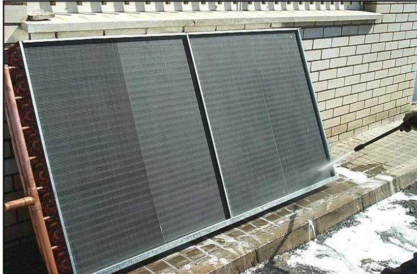
3.- Aplicación mediante equipo a presión del inhibidor VpCI-386. Esta operación ha sido realizada mediante un equipo convencional manteniendo una presión de trabajo de 7,5 bares y mediante utilización de una boquilla del nº 21. Para la aplicación del inhibidor se ha procedido a realizar un tintado previo del mismo con el objeto de poder establecer un seguimiento preciso del área protegida al mismo tiempo que aporta un factor estético de color según necesidades.
