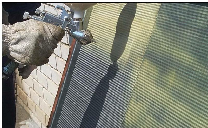
4.- Aplicación de una segunda mano del inhibidor VpCl-386 para de esta forma alcanzar el espesor mínimo aconsejado en torno a unas 75 micras.
