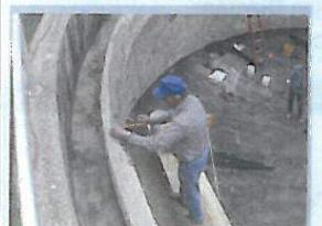
この1939年に建造された屋外排水処理タンクは、約20年補修されていない状態でした。露出した鉄筋及び腐食と破損箇所は修理が必要でした。
