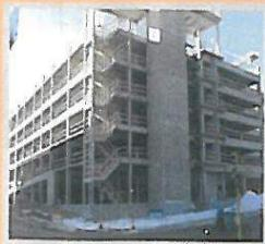
1,800台に入る6階建て駐車場は22,000立方ヤードのコンクリート全てを18~24時間以内に3,000psi以上の強度にする必要がありました。亜硝酸カルシウムベースの防錆剤は24時間以内では最小限の強度に見合はず、収縮ひび割れも発生しました。MCI-2005NSは要求スペックに見合い、30%も収縮を減少させ、0°C以下でも収縮ひび割れを抑えました。
