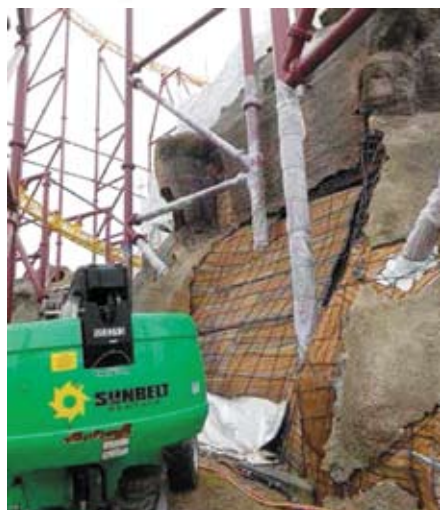
Slika 9. V okviru 10 mm, gumene obloge oko potpore cijevi i armatura koja se prekriva strojnim nanošenjem betona
