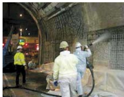
Slika 4. Liberty tunel prije popravka
