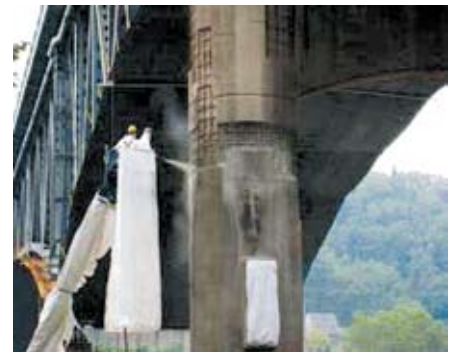
Slika 6. Rankin Bridge - popravak nosećih stupova
