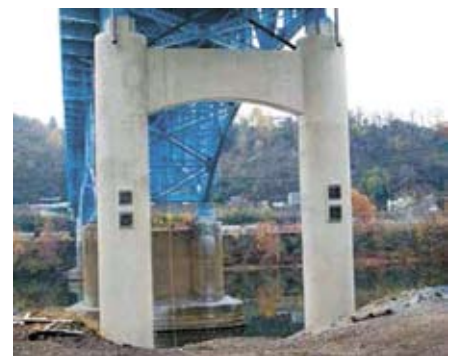
Slika 7. Rankin Bridge nakon popravka
