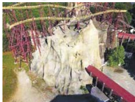
Slika 11. Pogled na završenu obojenu zonu zabavnog parka Volcano Kings Dominion u 2. i 3. zoni
