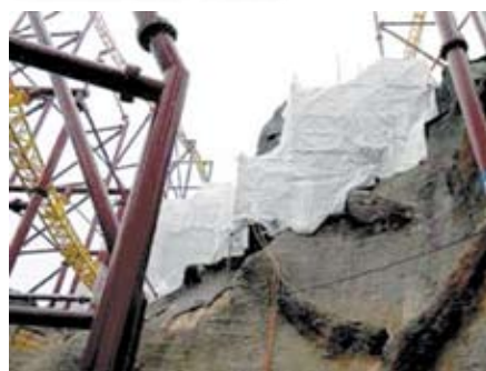
Slika 12. Skele i plastična zaštita nad 'planinskim' područjima koja treba popraviti
