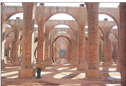
Rezervoari slane vode: beton sa VpCI-2005
