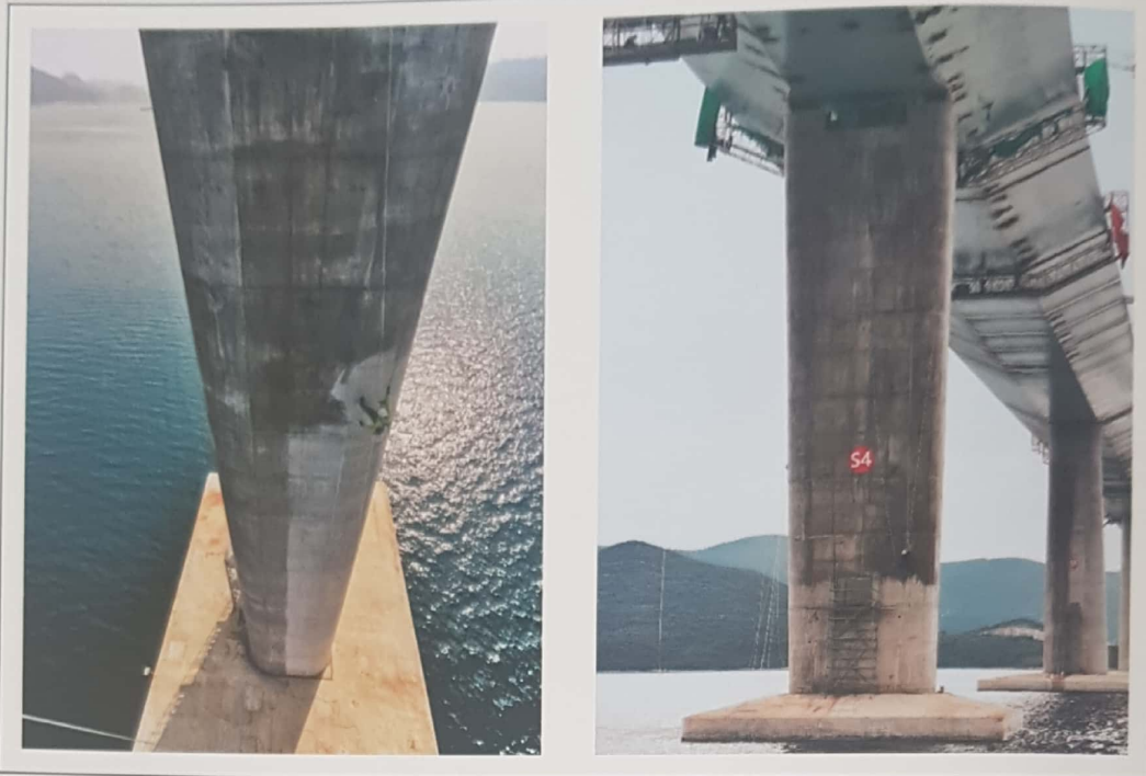
Slika 2. Nanošenje MCI@ 2018 na stupovima mosta Pelješac (tamniji beton na slici je beton s nanesenim silanskim premazom), listopad 2021.
