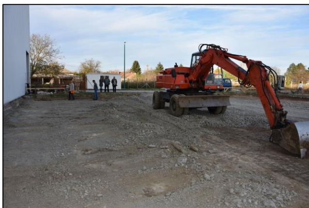
Gradnja nove tvornice je u punom jeku.
